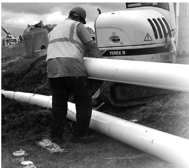
图1 准备回拖铺管施工
