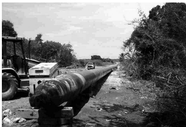
图2 准备回拖的钢质天然气管道
