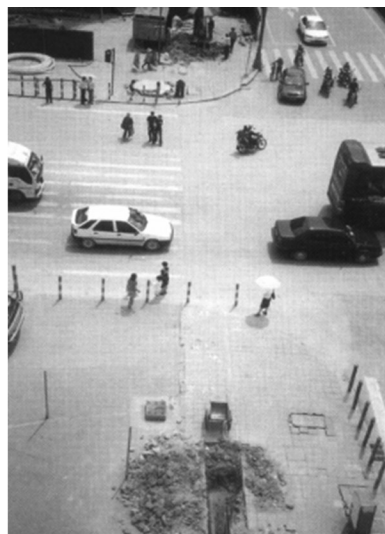
图1 南京十运会架空线入地综合管道整治工程
