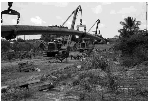
图3 在回拖过程中辅助钢管进入钻孔
