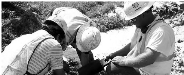
图1 安装拉力测量器
