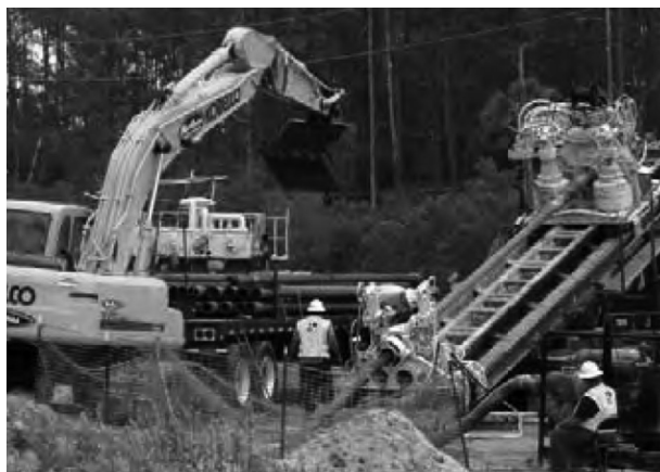
图1 该工程采用回拖力为330,000-lb至60,000-lb的钻机
