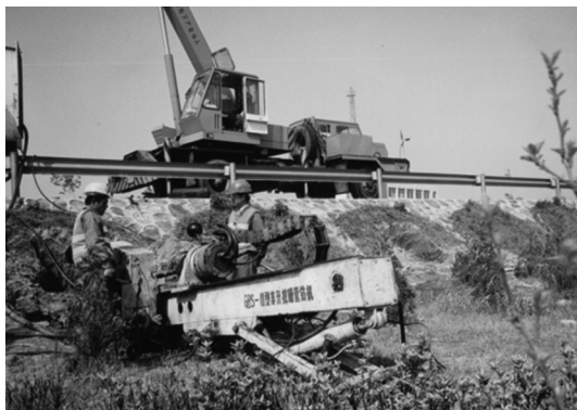
图2 水平定向钻进穿越沪宁高速公路
