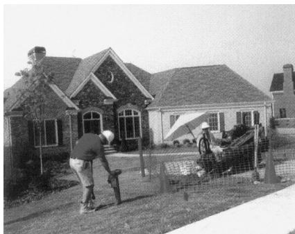
图1 入户光纤网络施工
