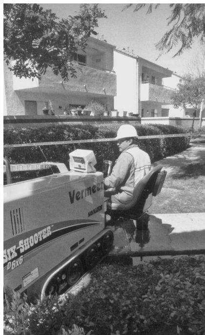
图2 施工钻机设备
