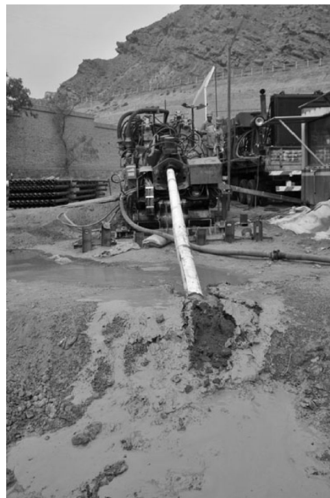
穿越施工现场
