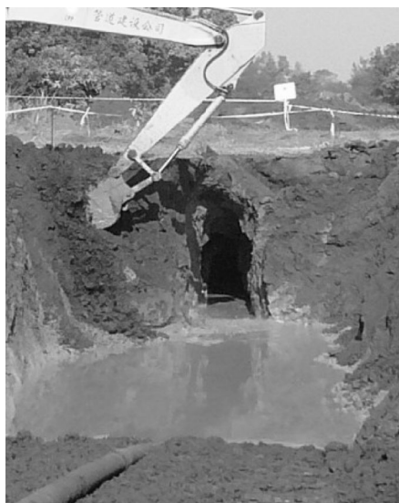
图2 多级扩孔后形成的长圆孔
