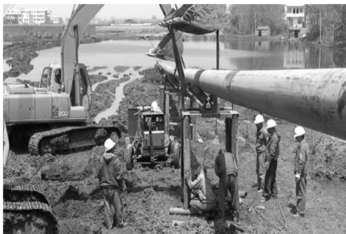
图 3 采用发送架进行回拖管施工
