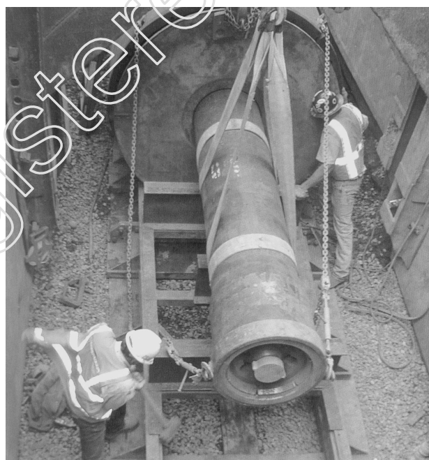
图 1 BT 非开挖分公司在 Pogosa 温泉镇 160 号高速公路下采用 24 英寸夯管锤铺设直径 84 英寸钢套管
