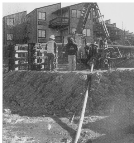
图 2 穿越潮汐河流施工
