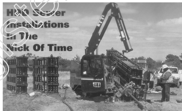
图 1 工地使用的 JT8020 Mach 1 型水平定向钻机
