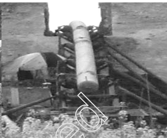
图 3 采用发送架进行回拖管施工
