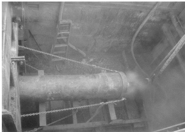
图 3 位于夯管工作坑中的钢套管和夯管锤连接装置
