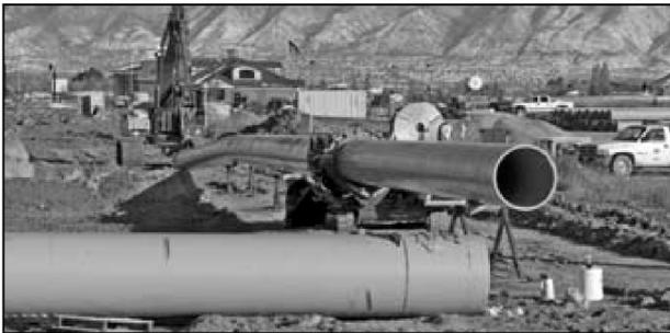
图 25 Underground Solutions 公司的 Fusible PVC 产品
