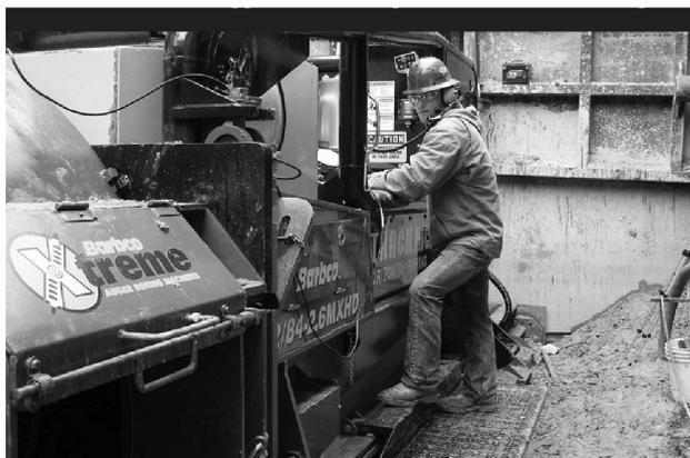
图 1 螺旋钻机施工现场
