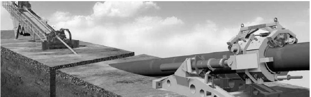
图 2 使用推管器助力回拖示意图
