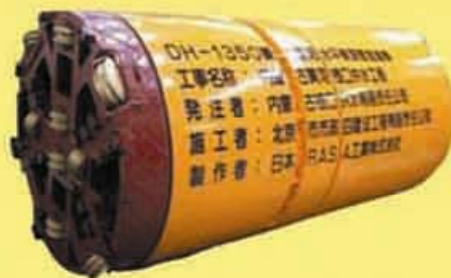
内蒙古渡口供水工程—穿越黄河 (卵石型)
