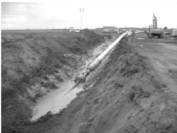
图 7 管道入口坑和回拖工序开始
