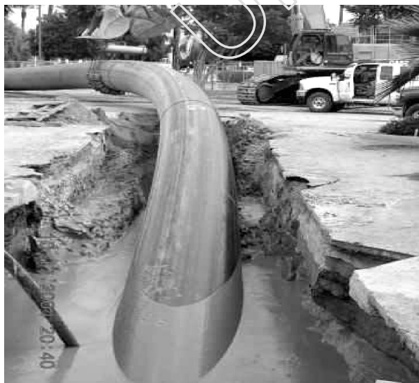
图 1 直径 54 英寸的 PE 管穿越铺设工程
