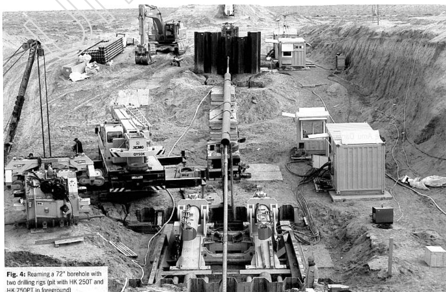
图 4 两台钻机扩 72"钻孔(工作坑里的海瑞克 250T 定向钻机和工地前方的海瑞克 750PT 推管机)
