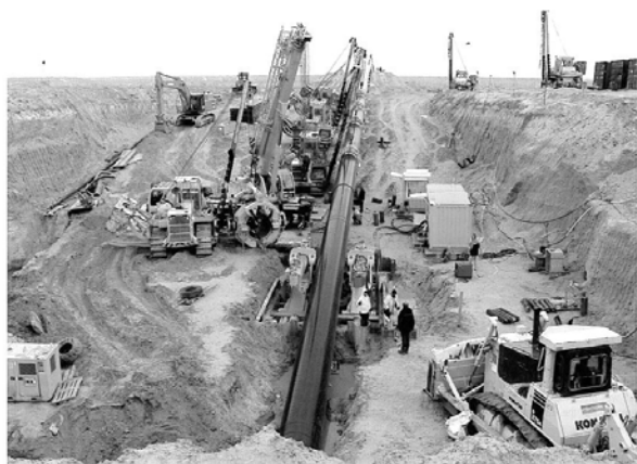
图 5 安装 56" 管线
