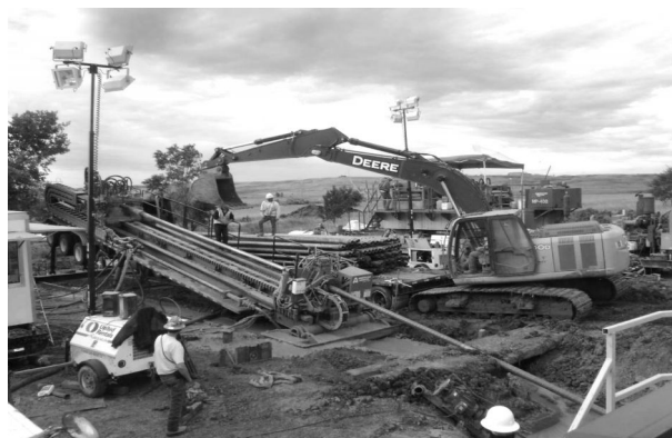
图3 回扩施工所用设备为 AA625 型钻机及其配套机具
