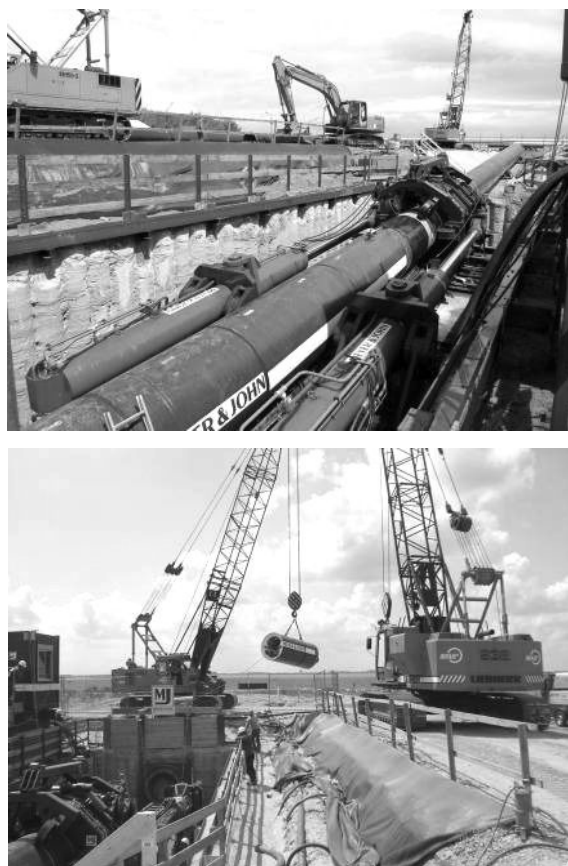
图 10 位于德国北部埃姆登城的第二个推管项目,现场安装
