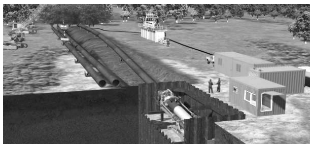
图4 推进铺管机将成段的管道推入地层
