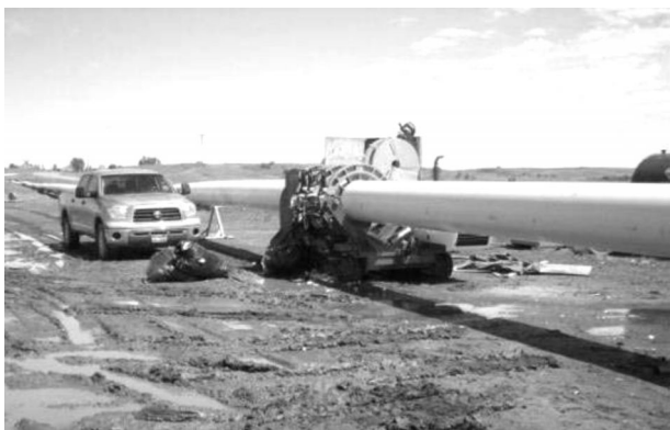
图 4 管道熔接(将需要铺入的管道连接在一起)
