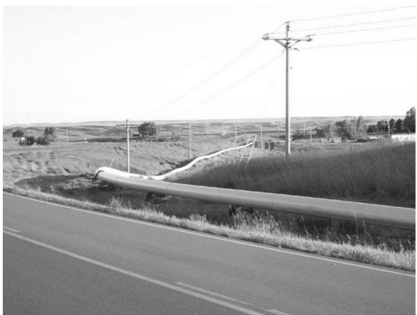
图 5 安放在辊轮上的管柱
