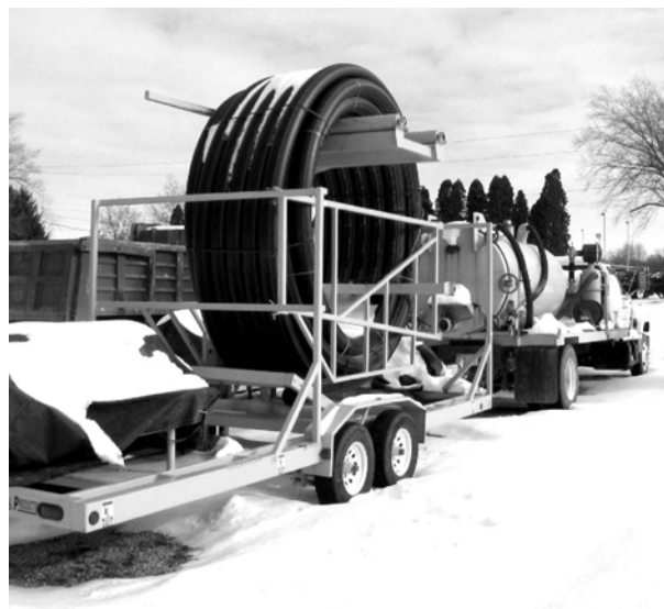
图 2 直径 6 英寸和 8 英寸的 PE 管穿越铺设工程
