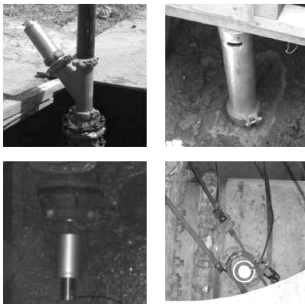
图 1 脉冲发生器连接方法
