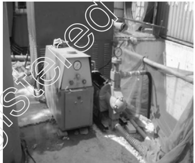
图5 触变泥浆注浆泵
