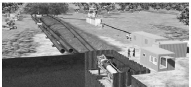
图9 管线截面被管道助推器推动
