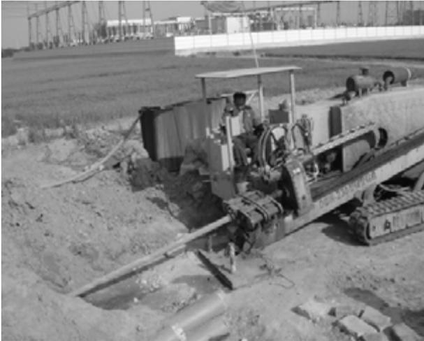
图2 钻机就位(下方为素混凝土承台,背后为高压变电站)
